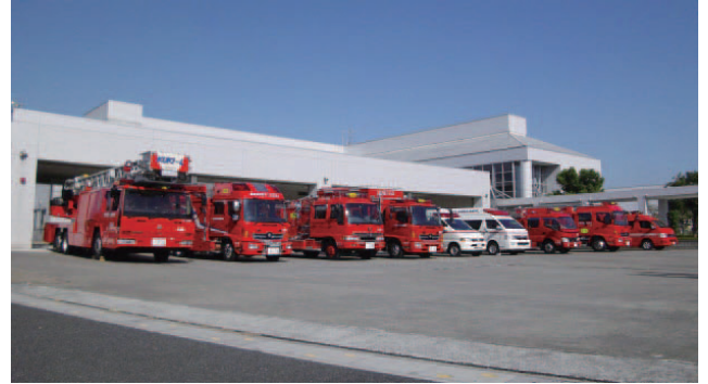
埼玉東部消防組合消防局庁舎
